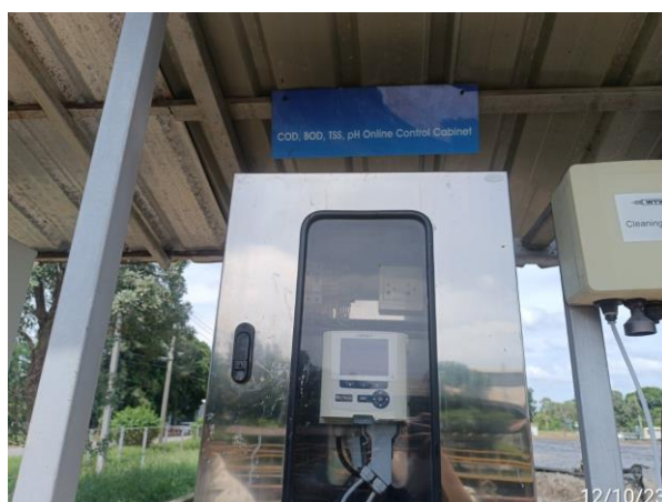
รูปที่ 9 อุปกรณ์ตรวจวัด COD Online บริเวณระบบบำบัดน้ำเสีย
