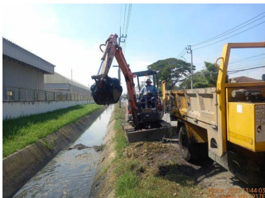
รูปที่ 5 ขุดลอกลำคลองเพื่อป้องกันการตื้นเขิน
