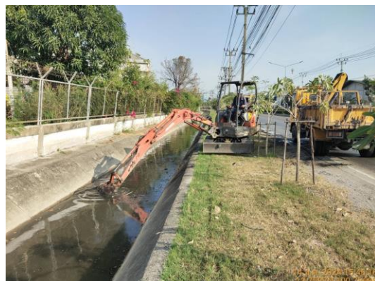
รูปที่ 5 ขุดลอกลำคลองเพื่อป้องกันการตื้นเขิน
